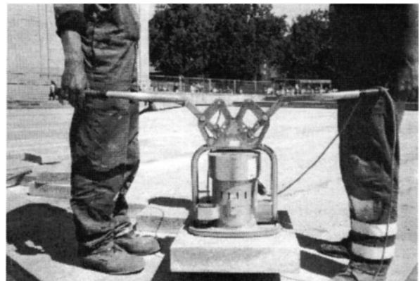
2 pav. Granito plokštės kėlimas pneumatiniu kėlikiu
