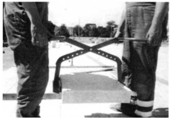
1 pav. Granito plokštės kėlimas mechaniniu kėlikiu
