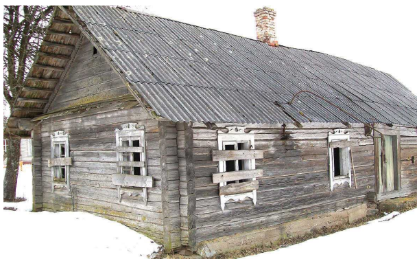
2 pav. Dieveniškių regioninis parkas, apleistas namas Poškonų kaimo gyvenvietėje, 2010 m.
